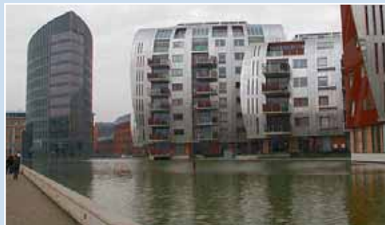
De vijver in het Paleiskwartier vangt zonnewarmte voor regeneratie van de aquifer voor warmtepompen
